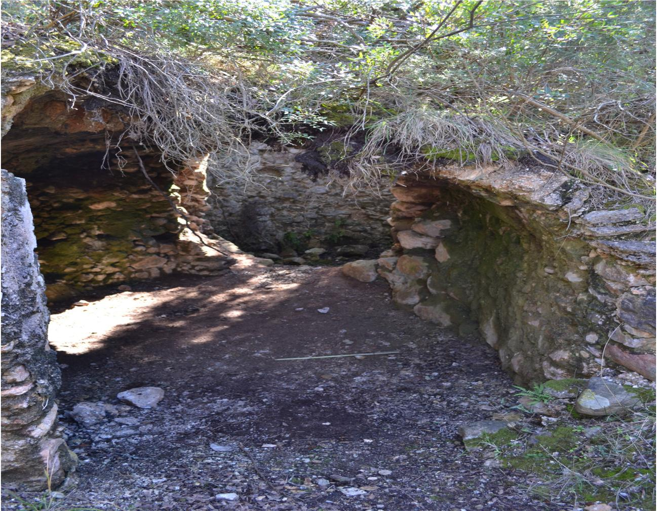
Fornace di calce -interno - sul fondo la camera di combustione
